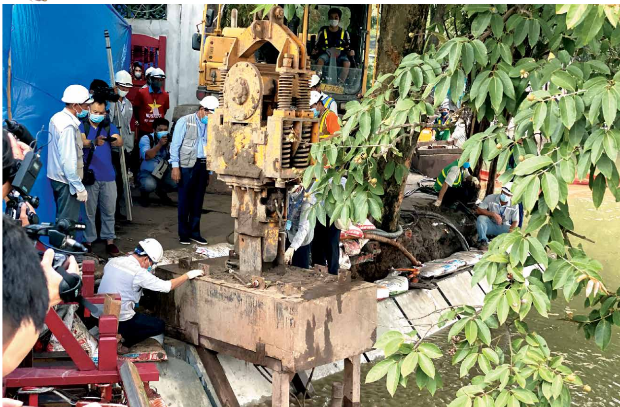
Công nhân thi công tại công trình kè hồ Hoàn Kiếm.
