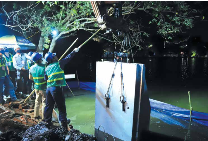
Thí điểm cải tạo bờ kè Hồ Gươm bằng khối bê tông cốt sợi đúc sẵn.
