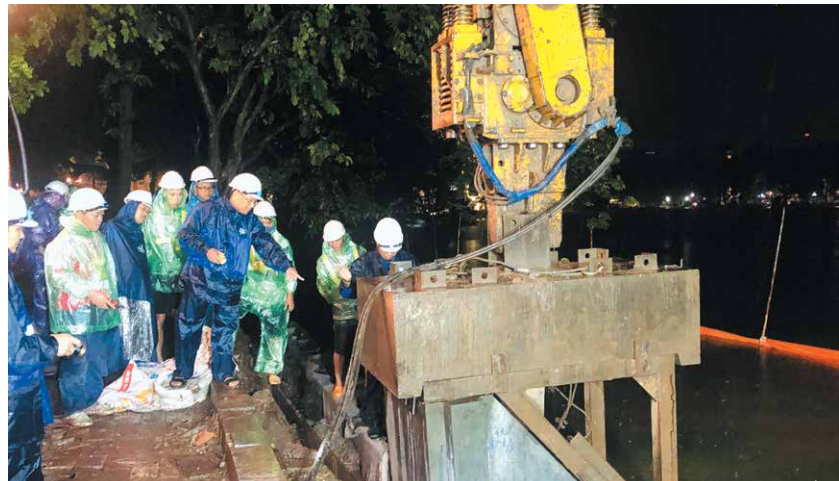
Thí điểm cải tạo bờ kè Hồ Gươm bằng khối bê tông cốt sợi đúc sẵn.
