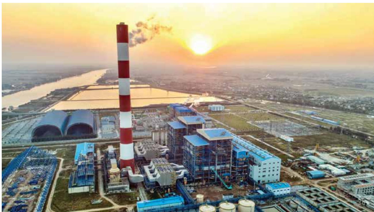
Hy vọng dự án Nhà máy Nhiệt điện Thái Bình 2 hoàn thành đi vào hoạt động sẽ đáp ứng nhiều mục tiêu, kỳ vọng của người dân về phát triển kinh tế - xã hội.
