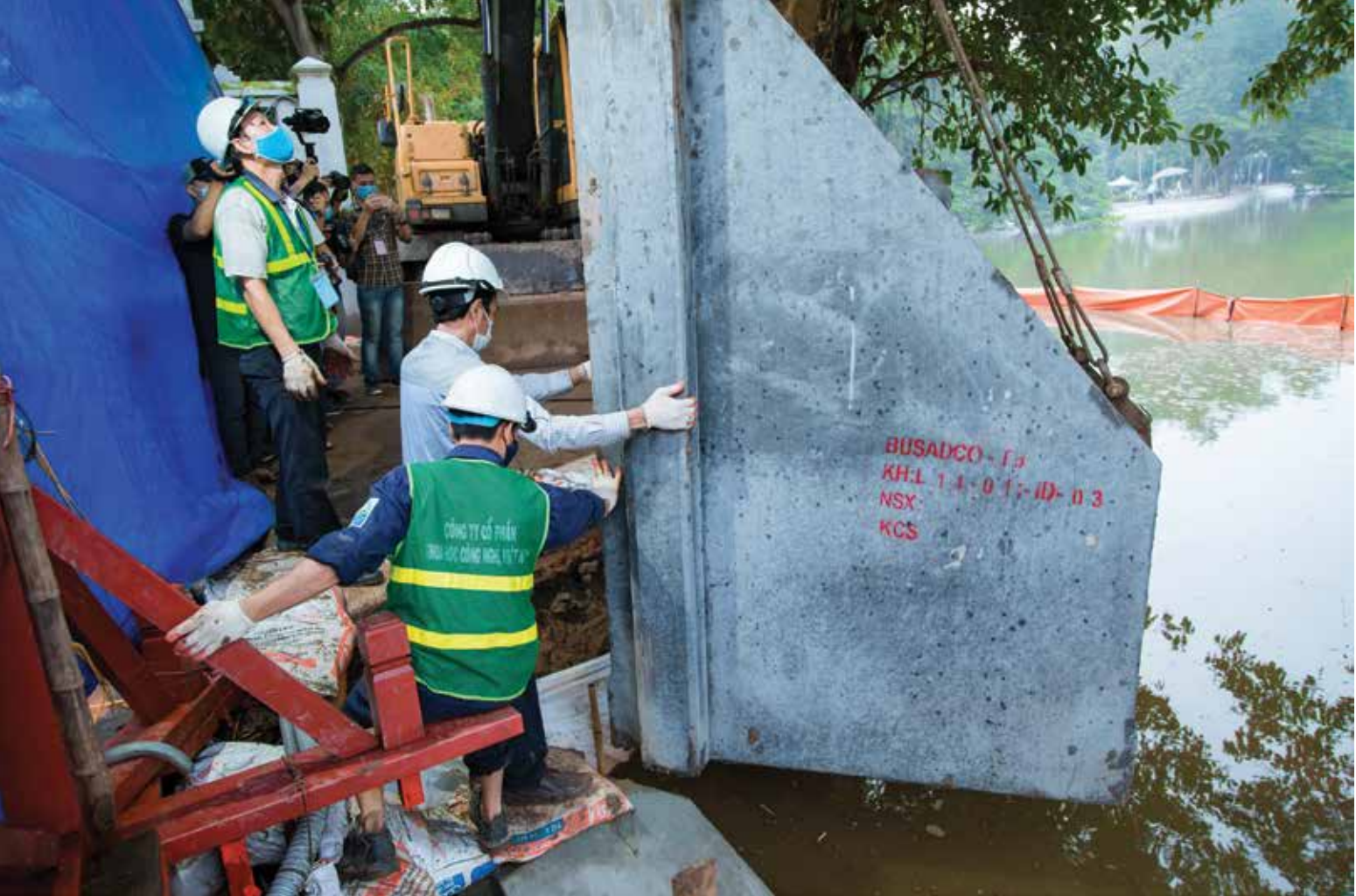
Công nhân của Doanh nghiệp Khoa học Công nghệ Busadco hạ cầu kiện bê tông xuống hồ Hoàn Kiếm, công trình lịch sử chào mừng kỷ niệm 1010 năm Thăng Long - Hà Nội, chào mừng Đại hội đại biểu Đảng bộ thành phố Hà Nội lần thứ XVII.
