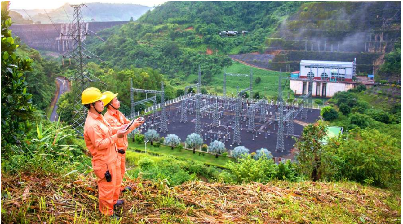
Cán bộ kỹ thuật Thủy điện Đồng Nai kiểm tra đường dây trạm phân phối 220kV bằng flycam.
