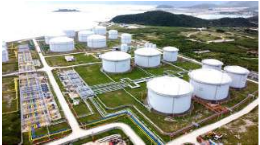
Một Nhà máy điện khí LNG.
