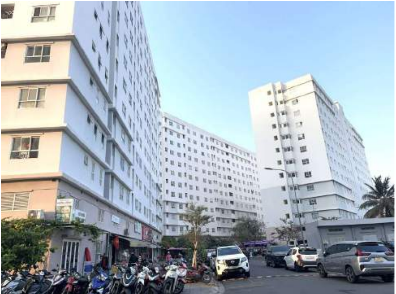
Xây dựng nhà ở xã hội cho công nhân cần sự gương mẫu đi đầu của các doanh nghiệp lớn.
