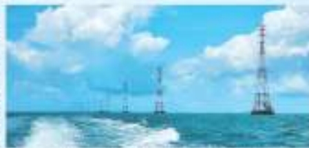
Thị trường điện cấp và vận hành đường dây 220kV Kiên Bành - Phú Quốc (Kiên Giang)
