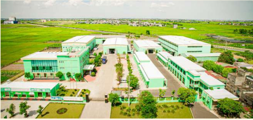
Thai Binh Seed đầu tư mạnh vào hệ thống nhà máy chế biến hạt giống, nhà máy gạo, kho bảo quản, dây chuyền sấy - làm sạch - phân loại đạt chuẩn quốc tế.
