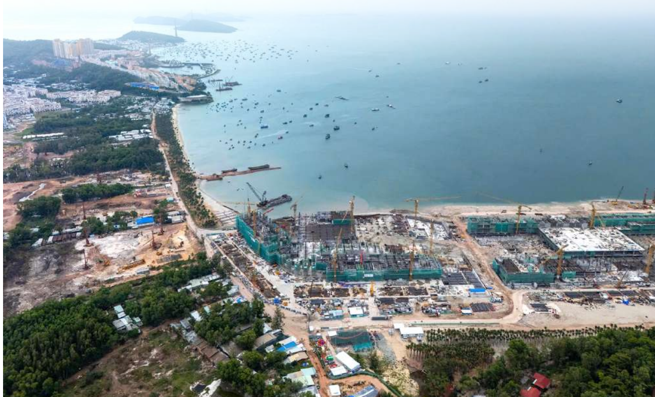
Một góc đại công trường phục vụ APEC 2027 nhìn từ trên cao.
